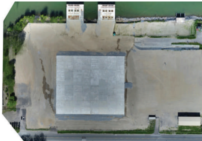
Installation actuelle de l'ancienne centrale électrique Crédit photo : Hydro-Québec
