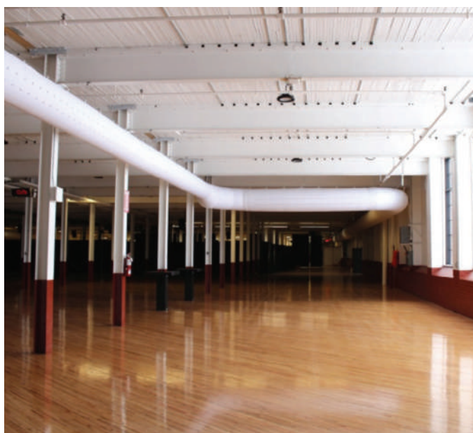
Vue intérieure du bâtiment principal de la Swift, avec une superficie de plancher de 65 000 pi 2 par étage. Cette portion du bâtiment a fait l'objet d'importants travaux de rénovation et de mise en valeur architecturale.
