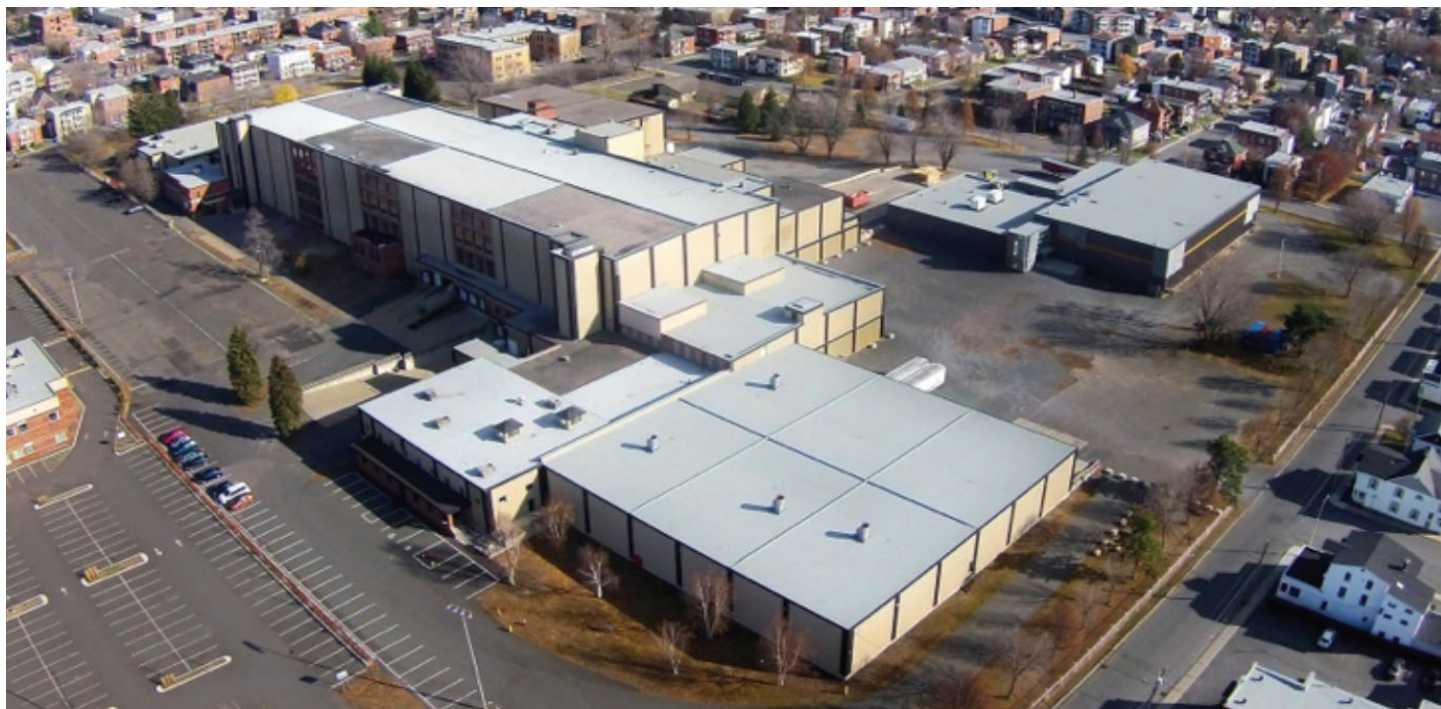
Photo aérienne du site de la Swift, 2015 Source : La Boîte d'urbanisme
