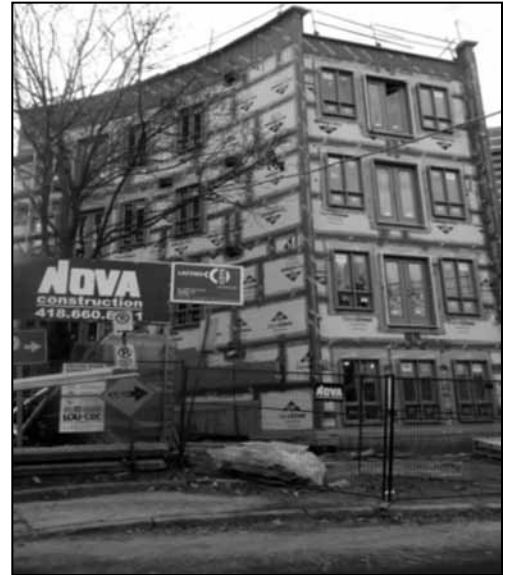
Projet en cours de réalisation Habitation Saint-Gabriel
