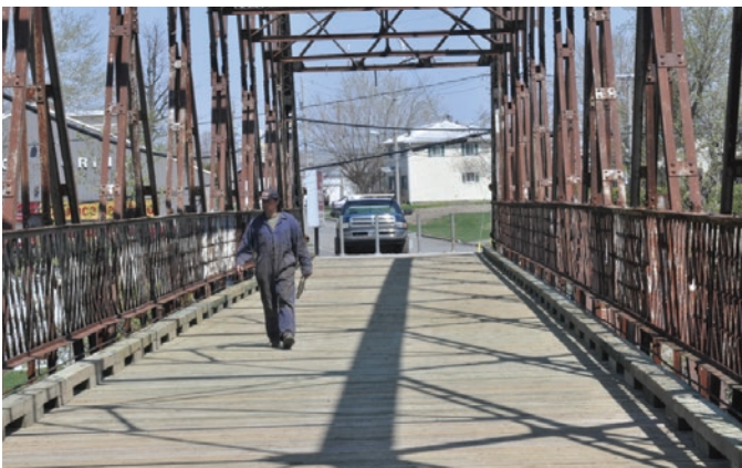
Photo du pont à la fin des travaux, avril 2009
