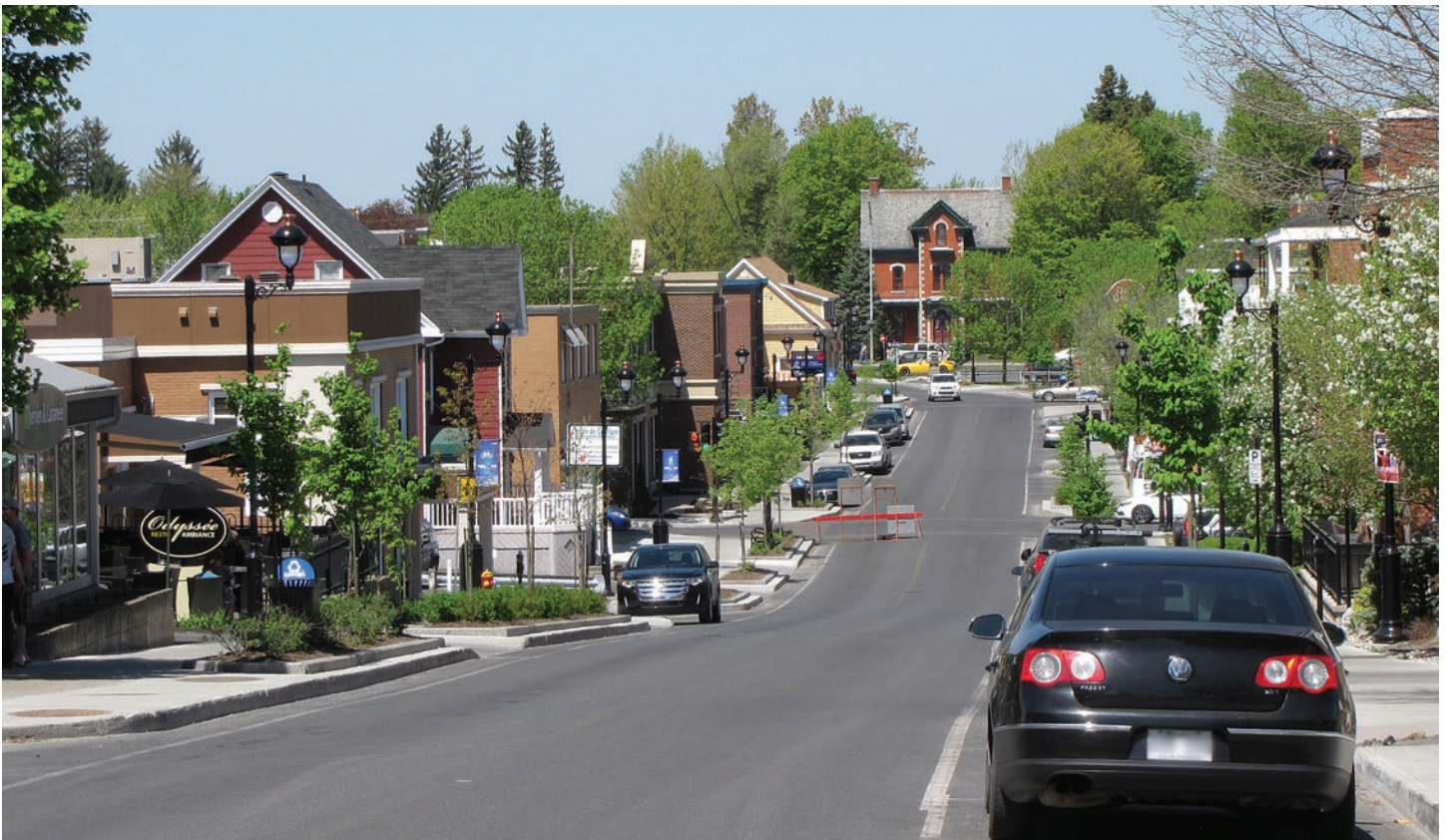
Artère commerciale importante de Drummondville à partir des années 1930, la rue Lindsay est l'une des trois rues commerciales d'ambiance du centre-ville. En 2011, la Ville procède à d'importants travaux d'enfouissement du réseau câblé et à l'aménagement de plusieurs îlots paysagers.
