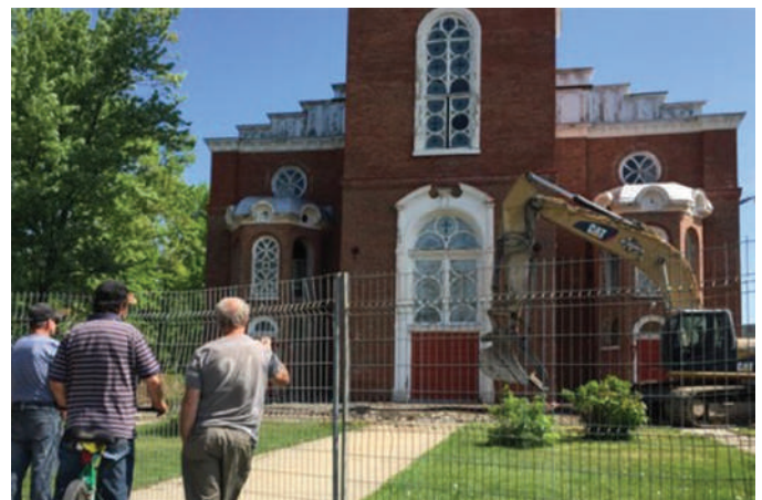
Démolition de l'église Saint-Thomas à Pierreville
