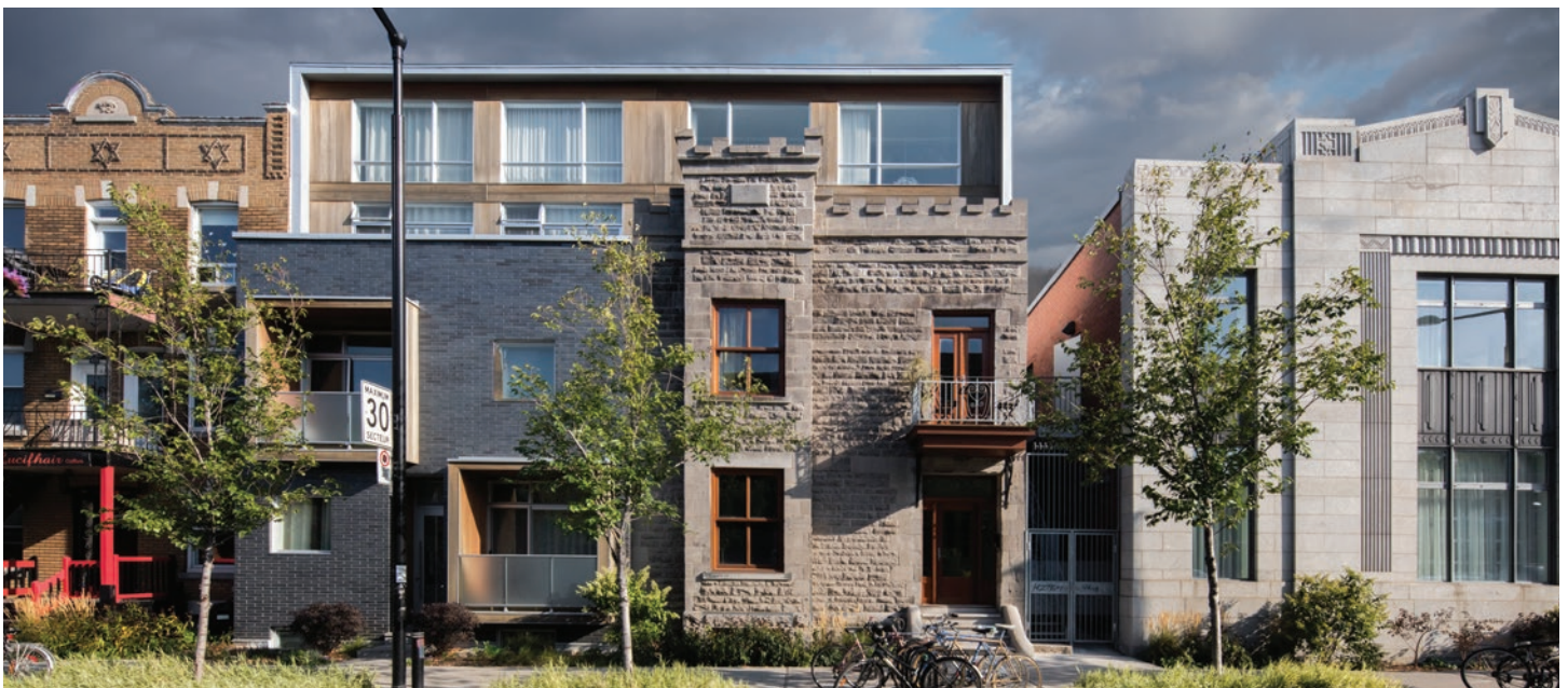
Les critères de PIIA constituent un outil extraordinaire pour créer le patrimoine de demain tout à assurer son harmonie au cadre architectural existant.
