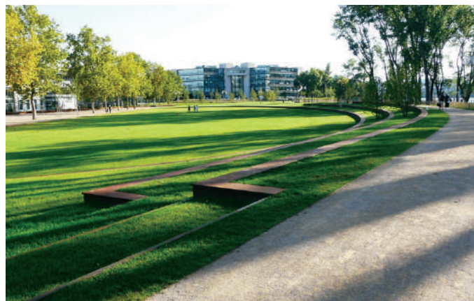
Bassin de rétention multifonctionnel du Parc des berges de Lyon, France Crédit : Vinci Consultants
