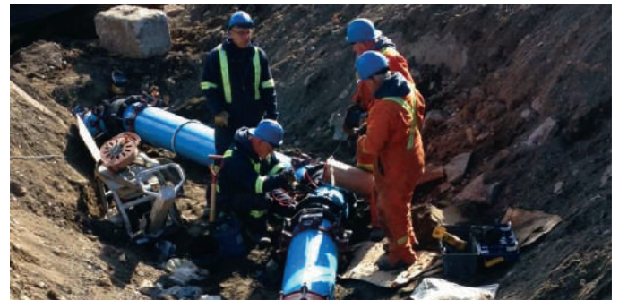
Travaux d'infrastructures réalisés par la Ville de Montmagny dans le cadre de son plan d'intervention pour le renouvellement des conduites d'eau potable, d'égouts et des chaussées Crédit: Ville de Montmagny
