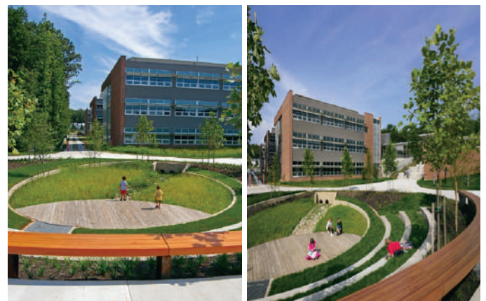
Bassin de rétention multifonctionnel du Manassas Park City Elementary School, Manassas, Virginie, États-Unis Crédit : Vinci Consultants
