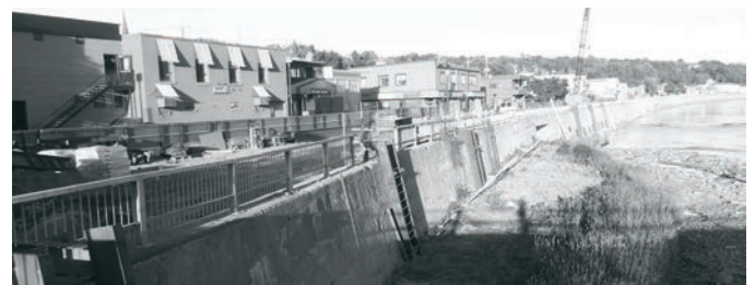
Travaux de revitalisation Saint-Georges, Rues principales
