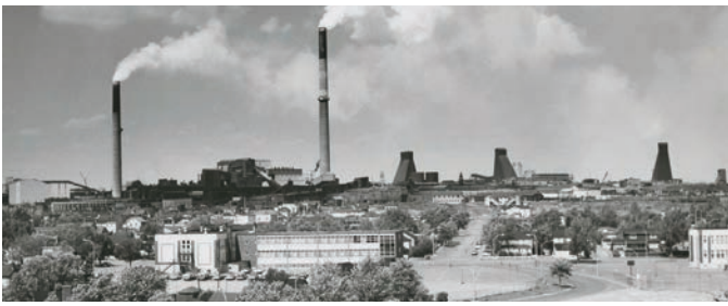
Photo : Fonderie Horne : vue du lac Osisko, 1976 Crédit : BANQ
