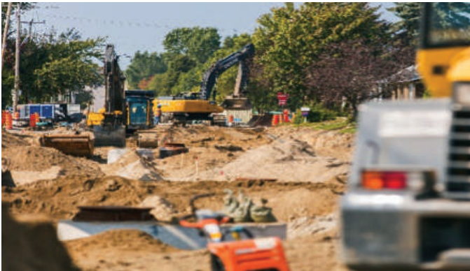
Source : Ville de Trois-Rivières- Bronde, rue Saint-Maurice pendant les travaux
