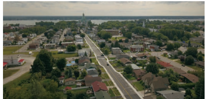
Source : Ville de Trois-Rivières-Bronde, rue Saint-Maurice, après la réalisation des travaux
