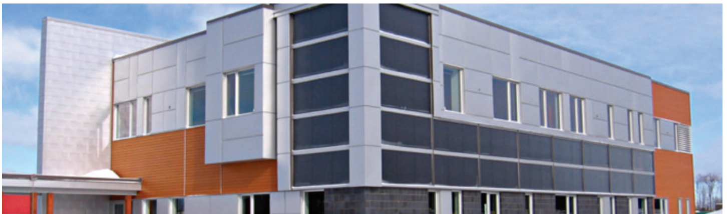
Exemple de revêtement composé de panneaux énergétiques : le bâtiment de l'entreprise Gaudreau Environnement sur le boul. de la Bonaventure à Victoriaville. Crédit : Dominic Guimond, urbaniste
