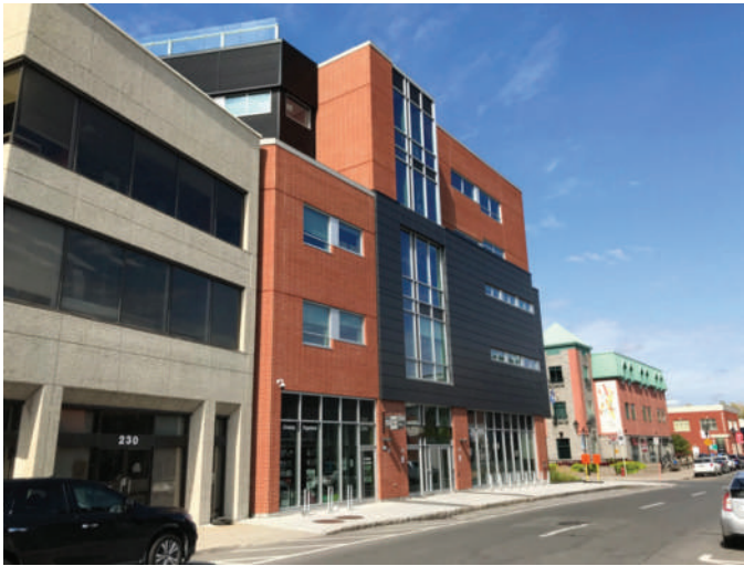
Autre exemple de revêtement composé de panneaux énergétiques : le pavillon de l'Université du Québec en Outaouais dans le centre-ville de Saint-Jérôme. Crédit : Patrice Furlan, urbaniste
