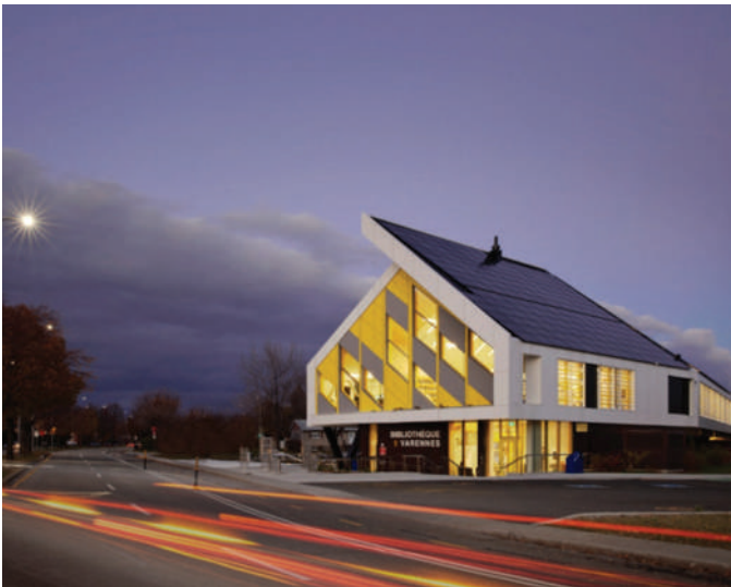
Bibliothèque, Ville de Varennes, vue sur la toiture et les panneaux photovoltaïques Crédit photo: Stantec
