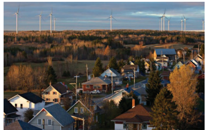
Parc éolien Viger-Denonville / Crédit photo : Joan Sullivan
