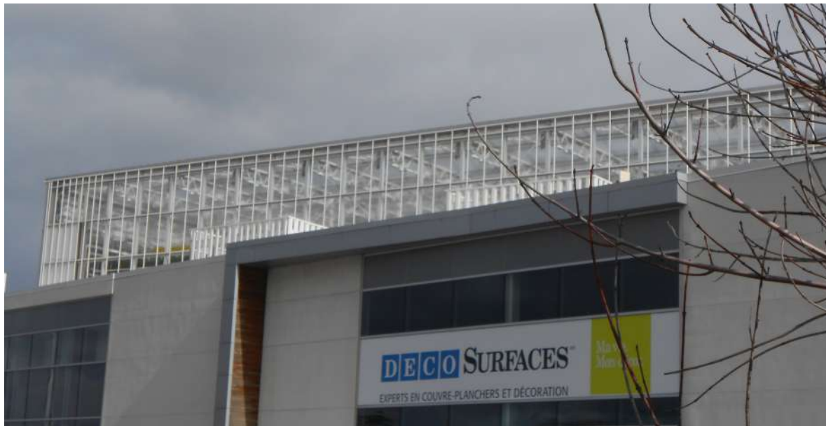
Image : Serres intégrées sur le toit d'un bâtiment commercial dans la ville de Laval.
