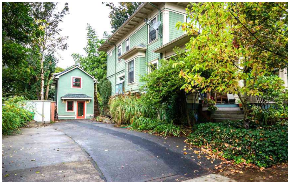
Une UHA détachée située sur un terrain résidentiel unifamilial à Vancouver, Colombie-Britannique. Elle offre un accès depuis la rue et dispose d'une case de stationnement propre. Crédit photo : Building an ADU.
