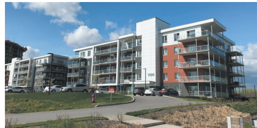
Bâtiments résidentiels à Trois-Rivières
